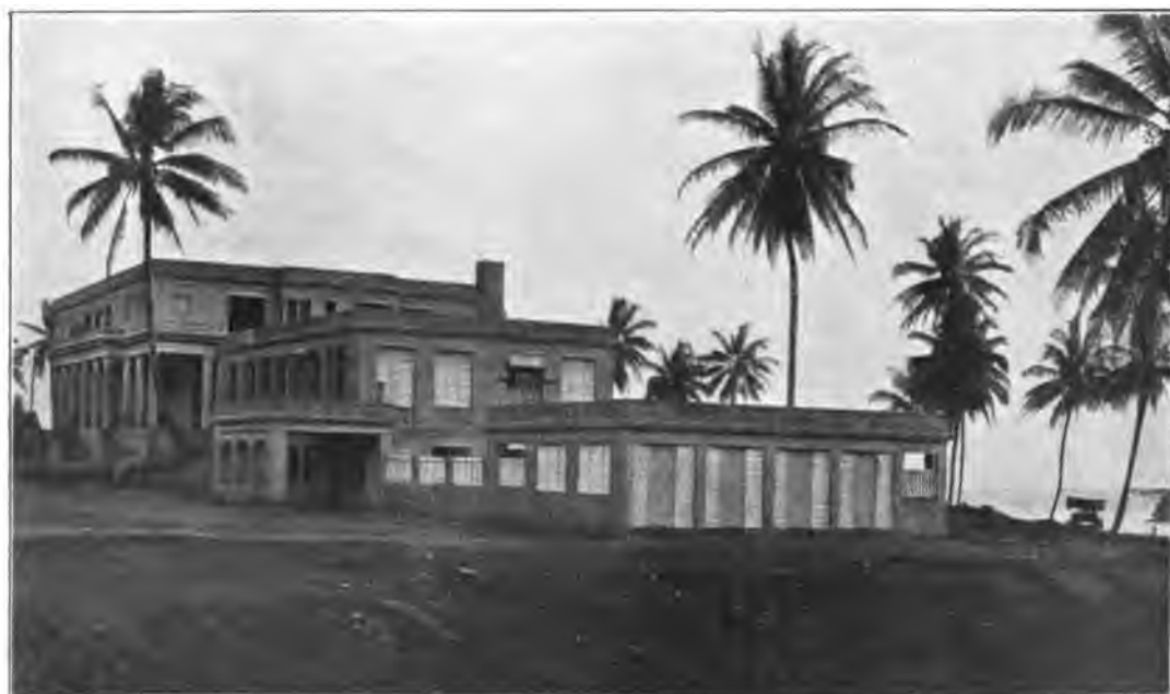
Abb. 39. Wohnhaus auf Jamaica. Arch. Chapman u. Frazer. — Ausgeführt von der Atlas Co. Handbuch für Eisenbetonbau. Ergänzungsband I. 5
